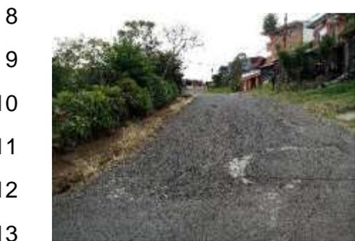
14 Mantenimiento: Se realizó un mantenimiento de una gran parte de la vía mediante un recarpeteo
